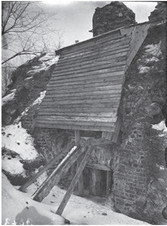
Kazimieras Vilkas. Rūmų sienos nuo Pilies kalno aikštelės atkasimas ir mūro virš įėjimo į šiaurinę patalpą apsauga nuo drėgmės . 1933. KPC PB, f. 6, ap. 1, neg. 3873
