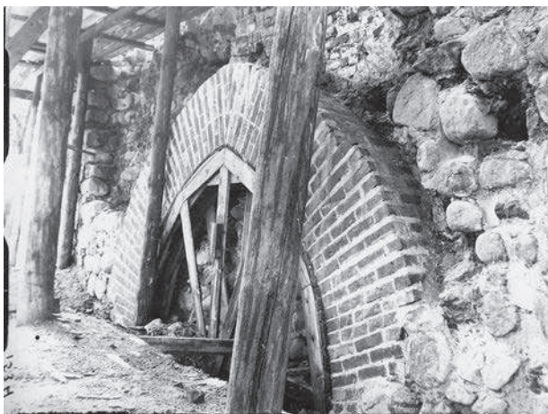
Kazimieras Vilkas. Rūmų sienos nuo Vilnios upės pusės paruošimas konservuoti. 1934. KPC PB, f. 6, ap. 1, neg. 3863
