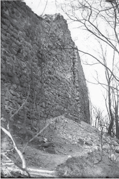
Janas Bulhakas (?). Aukštutinės pilies rūmų išorės siena nuo Vilnios pusės po mūrų atskilimo 1930 m. balandžio 6 d. rytą. 1930. KPC PB, f. 6, ap. 1, neg. 4186
