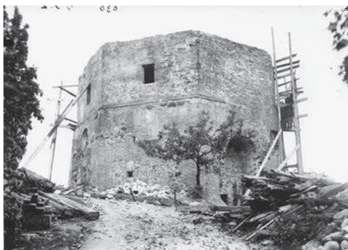
Janas Bulhakas. Medinio antstato demontavimas nuo Aukštutinės pilies pietvakarinio bokšto . 1930. KPC PB, f. 6, ap. 1, neg. 3657
